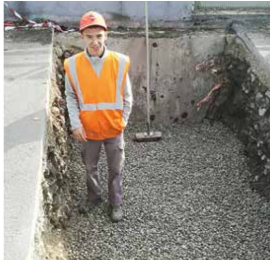
Mise en place d'une couche drainante en fond de fosse.
