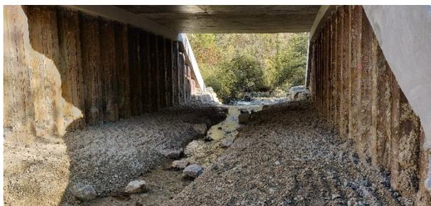
Figure 2 : planche photos du déroulement des travaux de suppression de la buse de Tacon.
