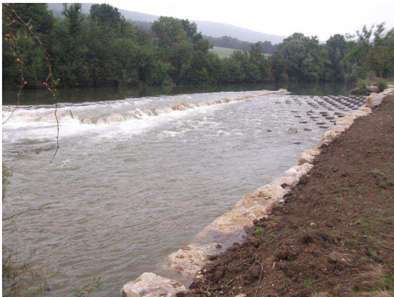
Rampe à macrorugosités sur la Loue à Lombard ©CEN RA
